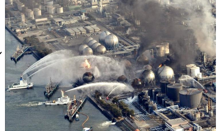
Incêndio em central elétrica próximo a Fukushima
