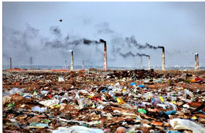
Usina de incineração de lixo em Bangladesh
